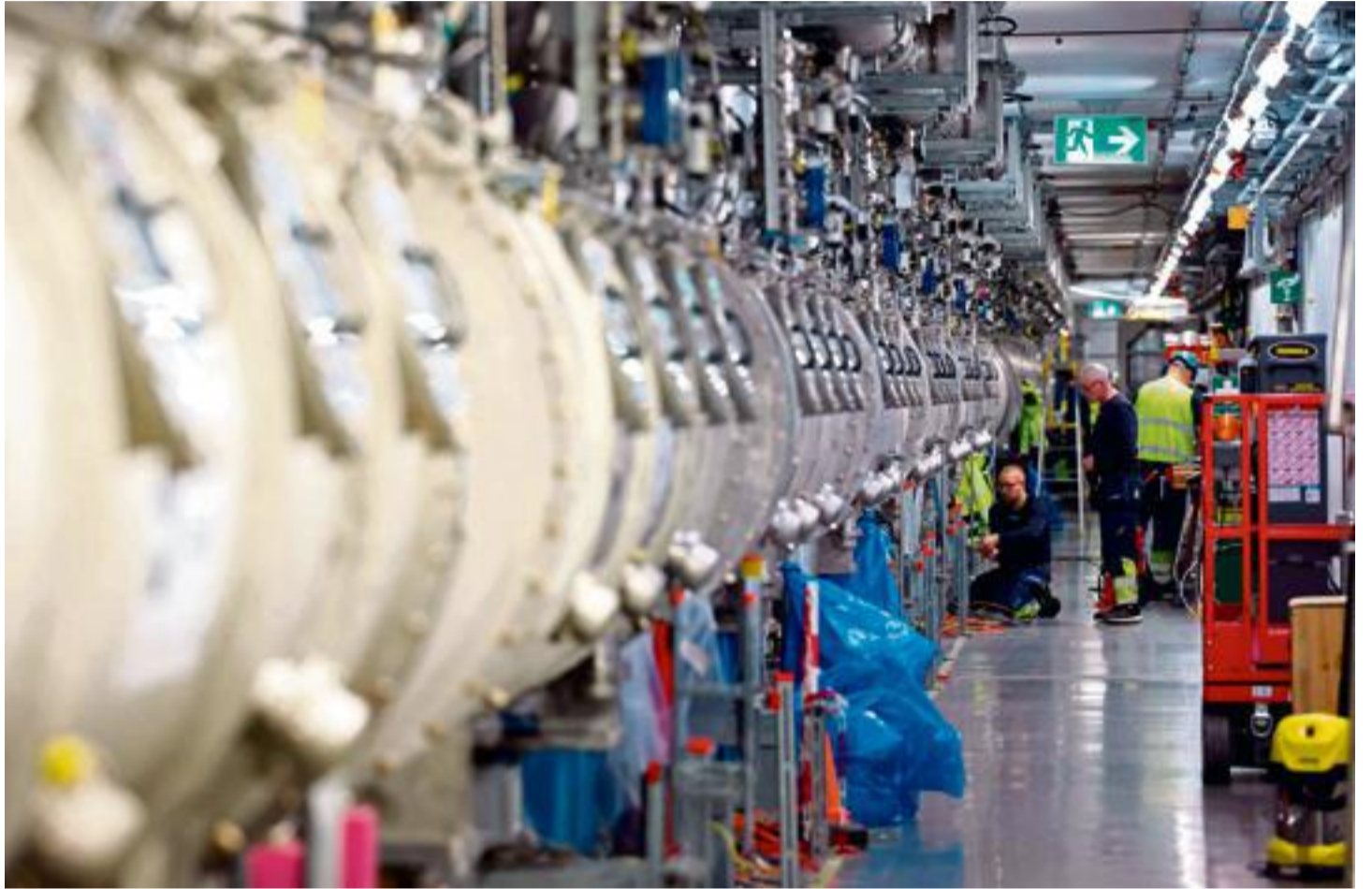
Une section de l'« European Spallation Source », en construction à Lund, le 26 avril. EMMANUEL DUNAND / AFP
