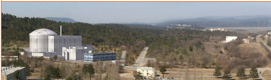
Le futur site du RJH à Cadarache avec le bâtiment (simulation) ©CEA/DEN
