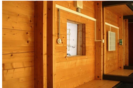
Une structure en bois sans aucun matériau ferreux
